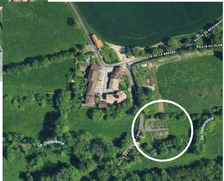
Les 2 stations d'épurations : Le Bourg (ci-dessus) et Beaumont (Ci-dessous)
