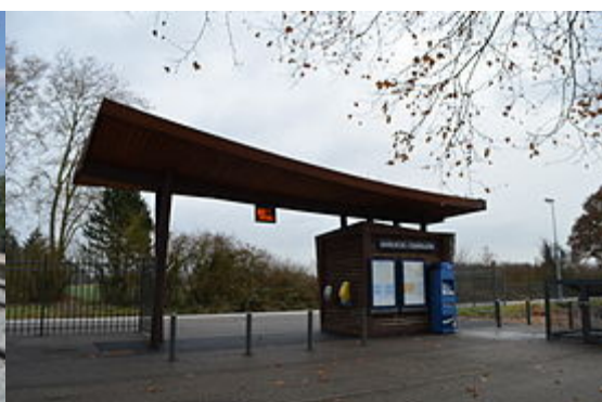
Halte Ferroviaire de Marlieux-Châtillon
